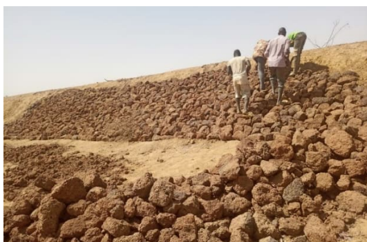
Ter bescherming van de dijk worden taluds Drinkbakken voor het vee, met voeten pompen volledig bedekt met uitgehakke rotsblokken
