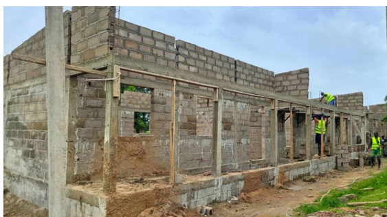
De ruwbouw van de school vordert gestaag
