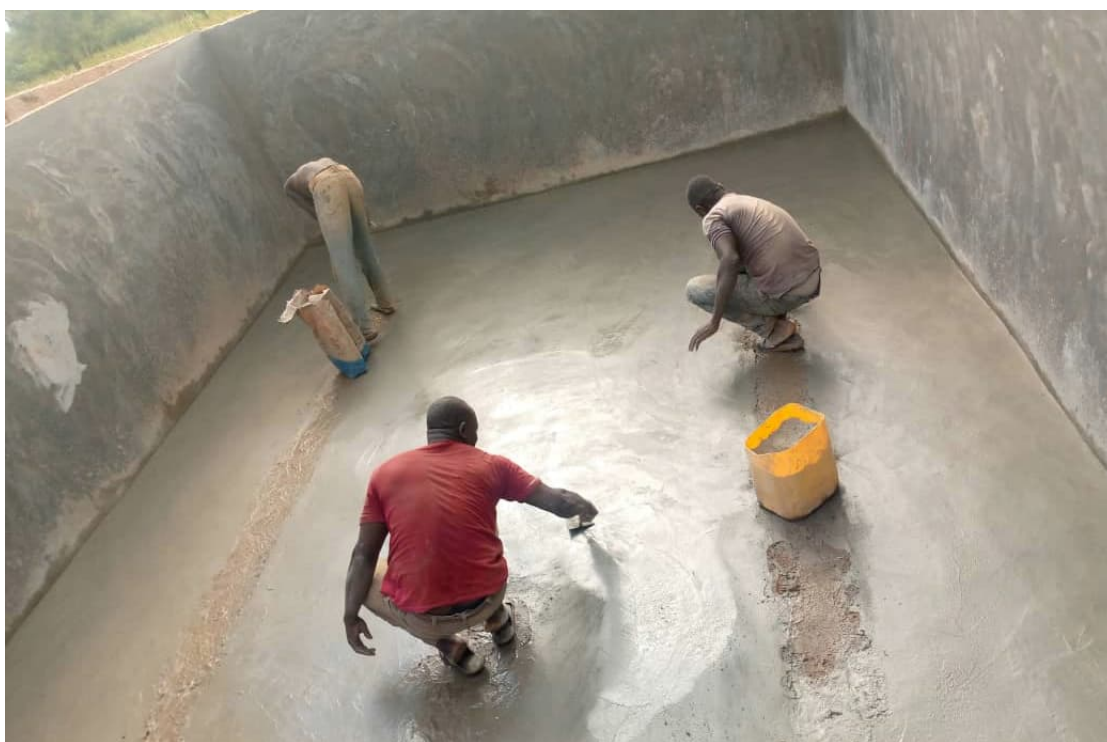
De afwerking in volle gang
