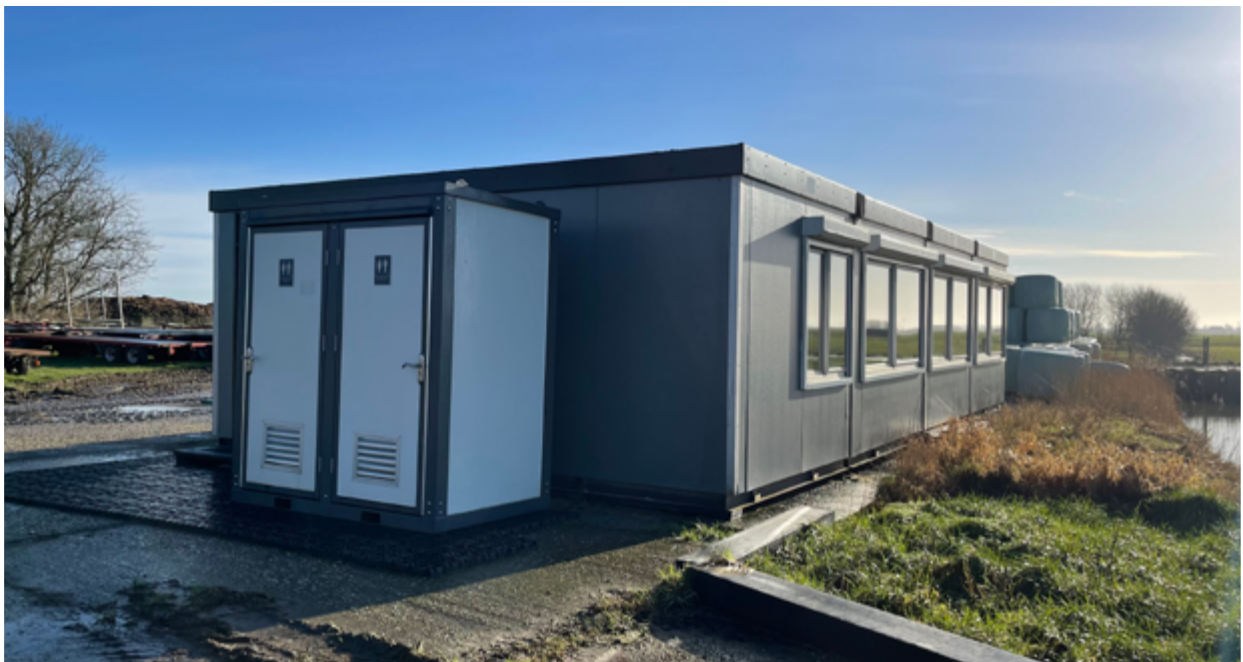
Bezoekerscentrum ANF in aanbouw.
