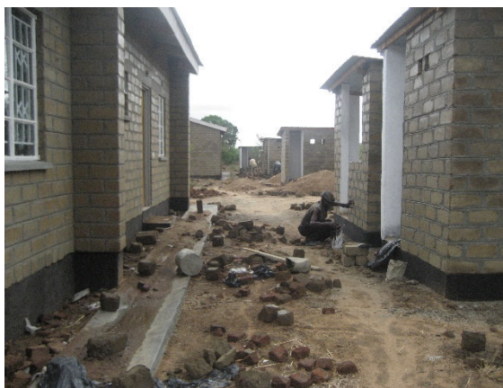
Afwerking van stafhuizen en latrines
