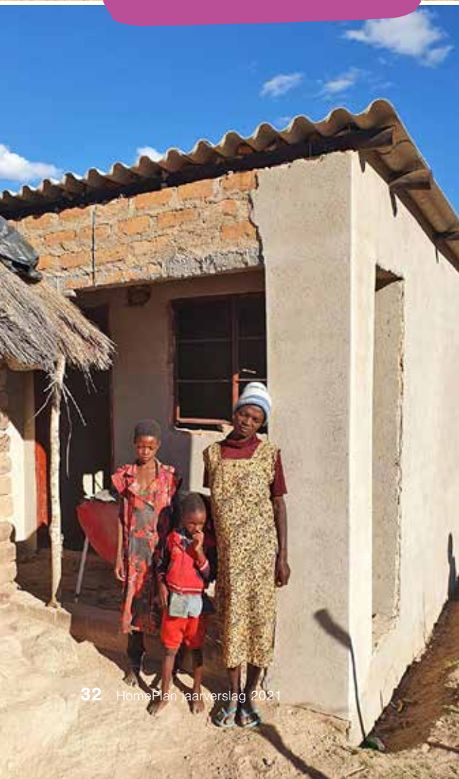
Bouw van nieuwe huizen in Zimbabwe
