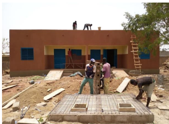
Personeelswoningen in aanbouw.
