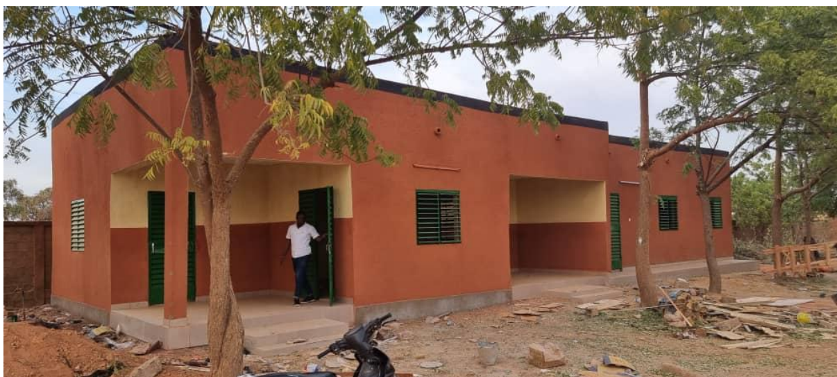
De verpleegpost is verbouwd tot trainingscentrum. In het oude deel is kantoorruimte en er is een groot lokaal aangebouwd.
