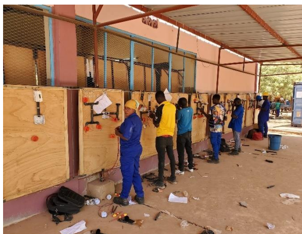
Een overkapping als uitbreiding van de praktijkruimte voor de opleiding tot elektriciens.
