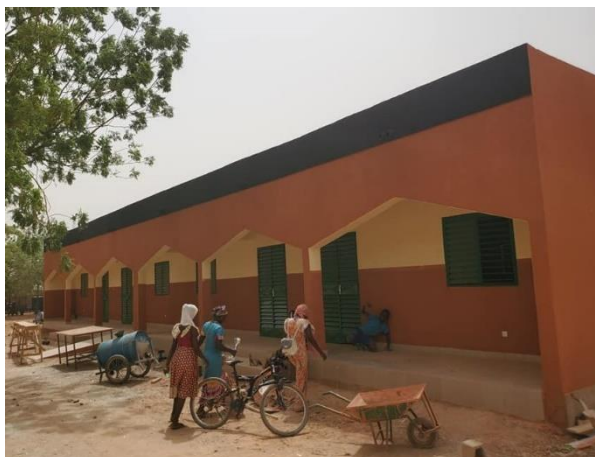
De nieuwe lokalen voor de naaiopleiding zijn gelijk aan de reeds bestaande lokalen.
