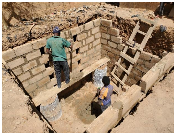
Aanleg van nieuwe latrines.
