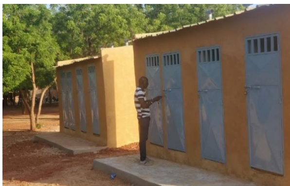
Nieuwe latrines bij de school in siguinvoussé.
