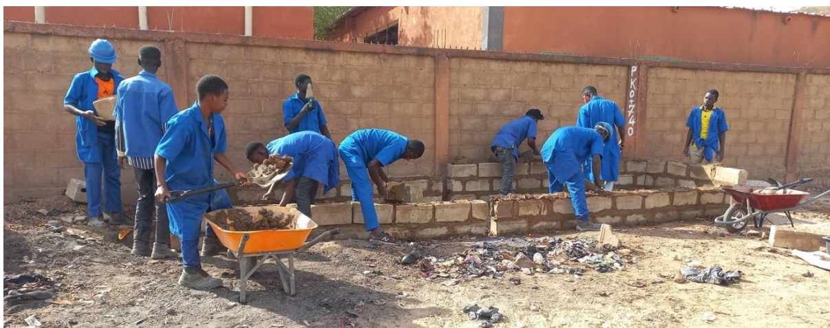
Praktijkles metselen voor de leerlingen van de opleiding civiele techniek op Onderwijscomplex Zodo.
