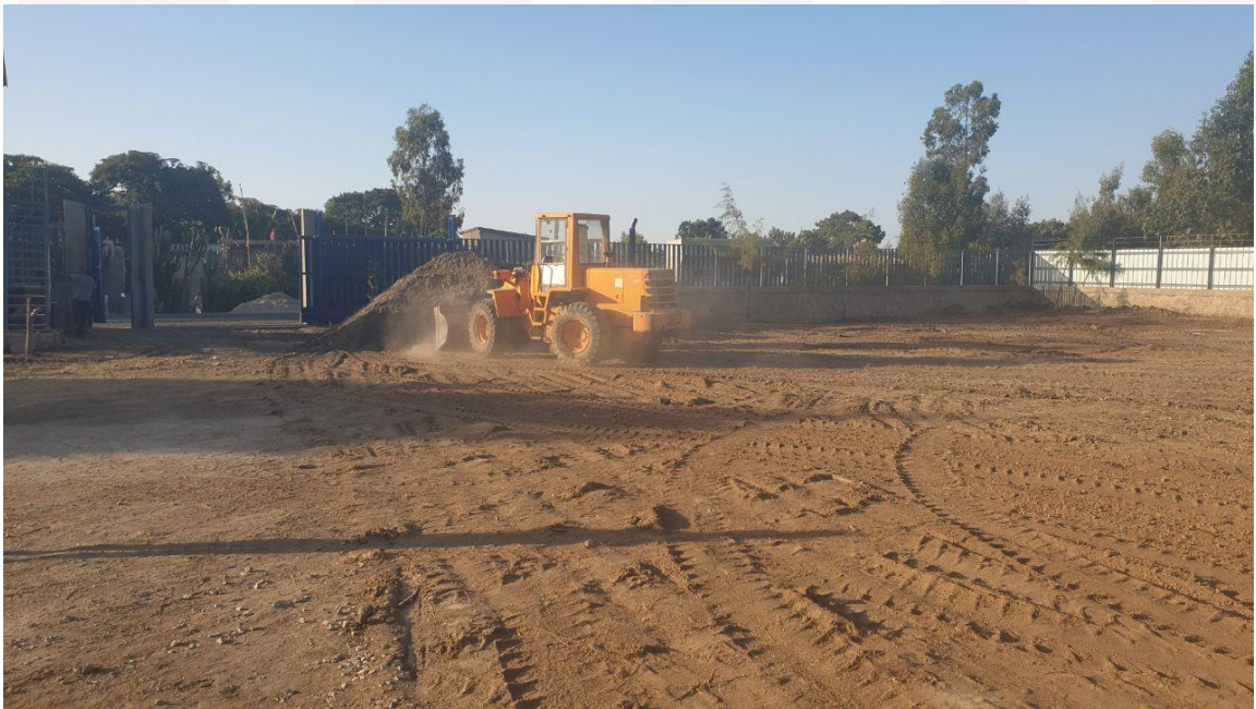
De egalisatie van de grond. De omheining is geplaatst. Uiterst links is de trap van de wachttorens nog net zichtbaar
