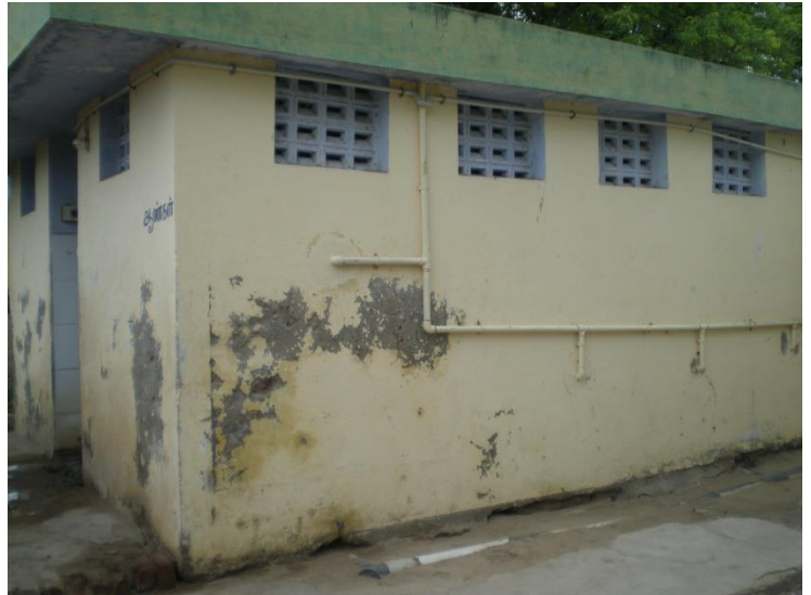
Bestaande toilet gebouw
