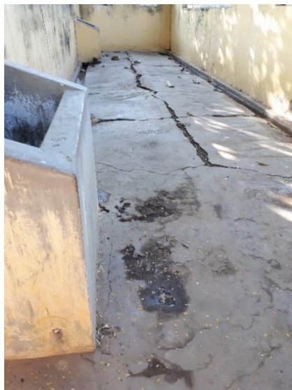
Vloer bestaande toilet
